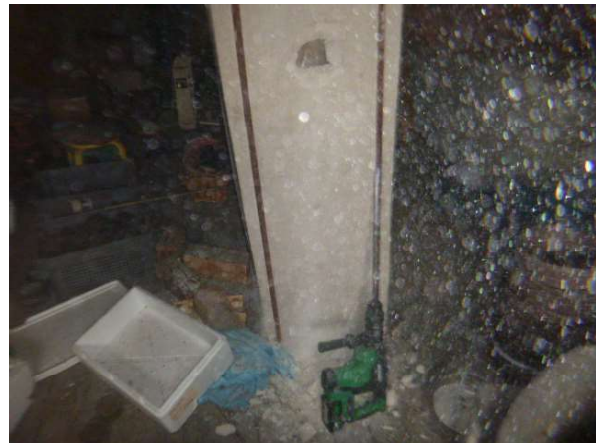
Inspectie schoorsteen woning
