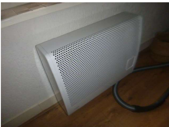
Gevelkachel niet asbestverdacht
