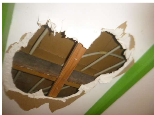
Inspectie boven plafond
