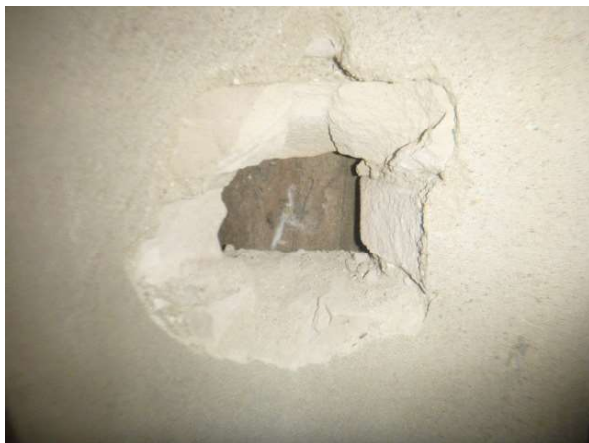
Inspectie schoorsteen woning
