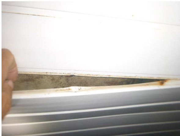
Inspectie achter schroten
