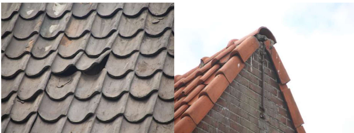
Openingen onder nok-, gevel- en dakpannen vormen een geschikte nestplaats voor huismus en gierzwaluw.
