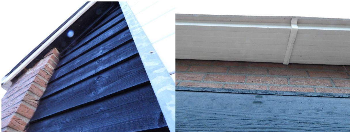
Foto links; de planken sluiten strak op elkaar aan. Foto rechts; de betimmering van het dak overstek sluit naadloos aan op de buitengevels.
