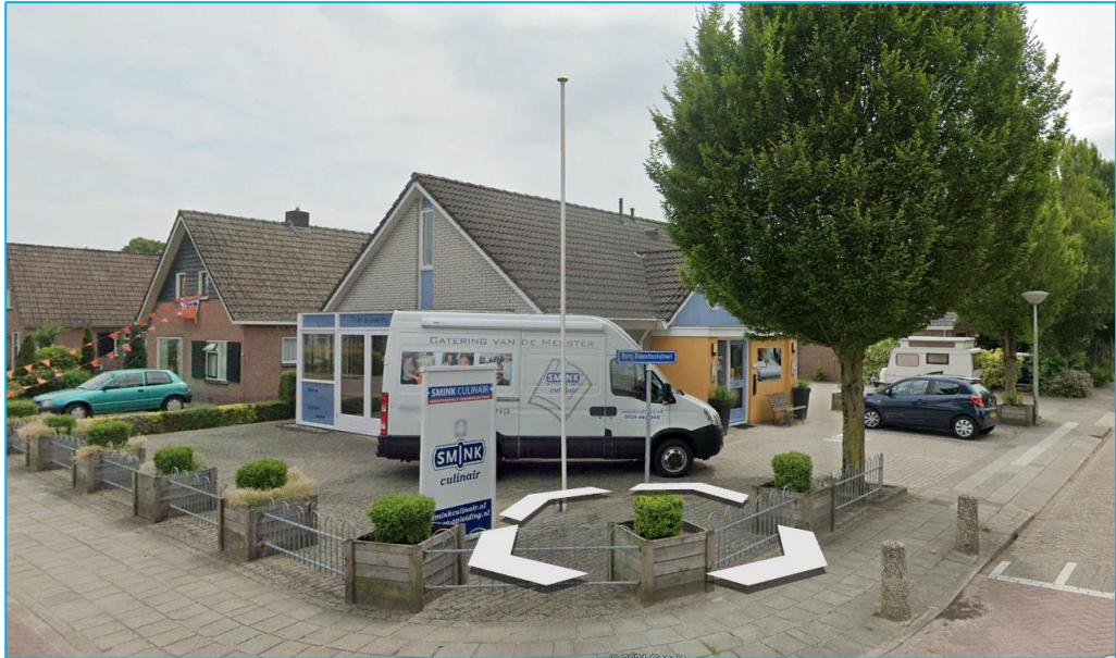
Fig. 1.2: Een weergave van de bestaande bebouwing in het plangebied (bron foto Google Earth)
