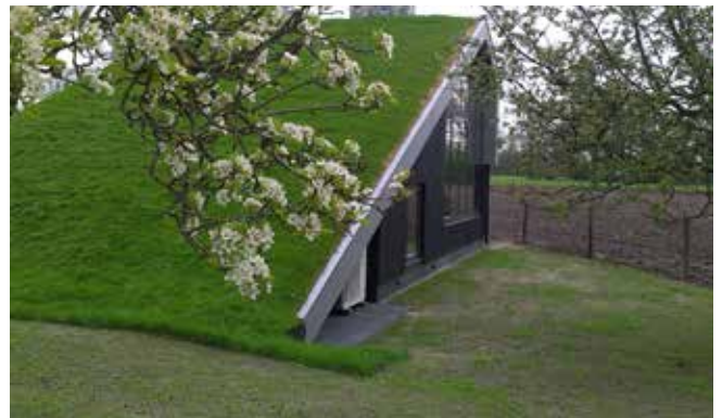
Referentie eigentijds ingepaste erfbebouwing (bron: HO - Holt-dijk, Markelo)
