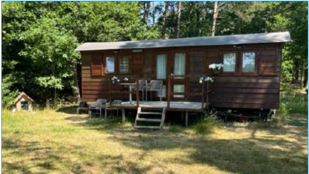
Fig. 2.1: Weergave bestaande bebouwing
